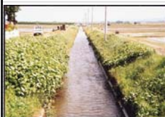
用水路(開水路)
