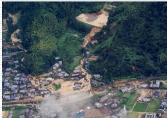
↑平成16年8月20日の台風15号による大雨に伴うため池決壊災害(愛媛県新居浜市臼切りため池) 17
