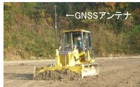
MC(マシンコントロール)ブルドーザ
