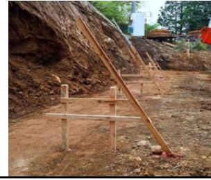
設計図に合わせて丁張り設置
