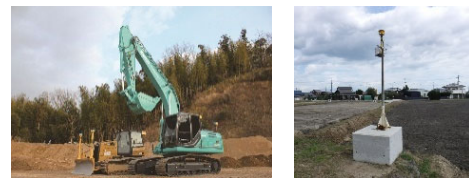
ICT建設機械
