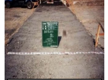
出来形管理の状況
