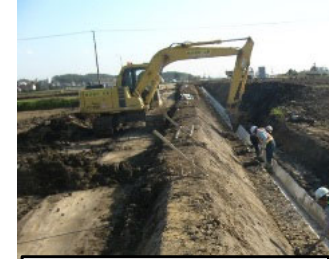
丁張りに合わせて施工
