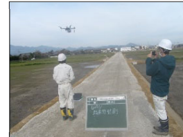
UAVによる3次元測量
