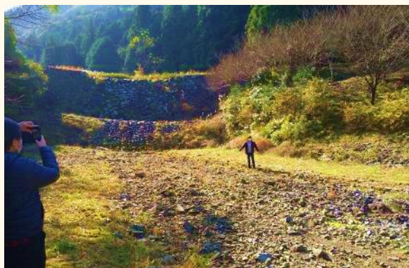
羽根谷砂防堰堤：海津市
