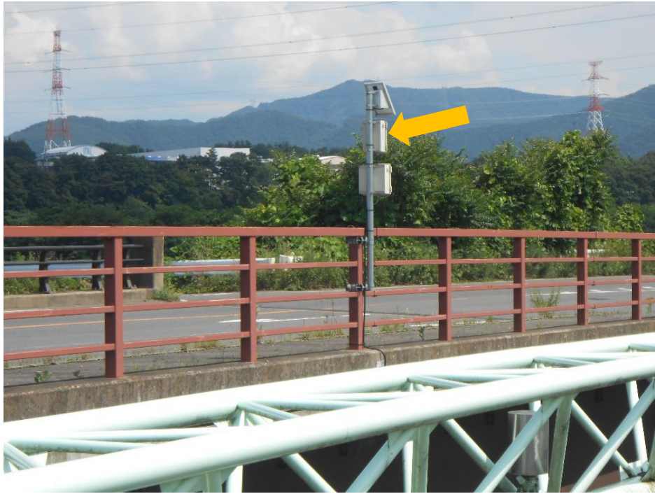
測定した橋梁の振動情報を送信
