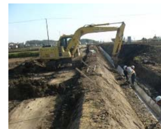
丁張りに合わせて施工
