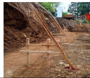
設計図に合わせて丁張り設置
