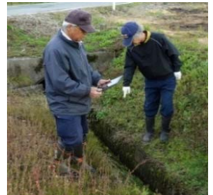
現地調査にモバイル端末を持ち出し、破損箇所の位置を地図上で確認。
