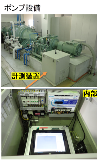
状態監視サーバ 計測した情報をサーバに蓄積 端末からアクセスし機能診断情報を閲覧 粒子数 酸化劣化程度 水分 時間
