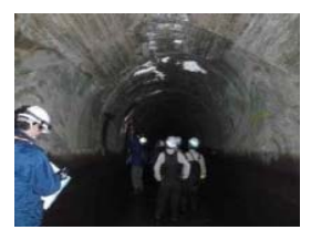
目視による点検調査
